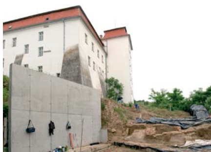
3 Pogled z območja prehoda med zahodnim in jugozahodnim stolpom proti gradu med izkopavanji (Foto: arhiv PMMS).
